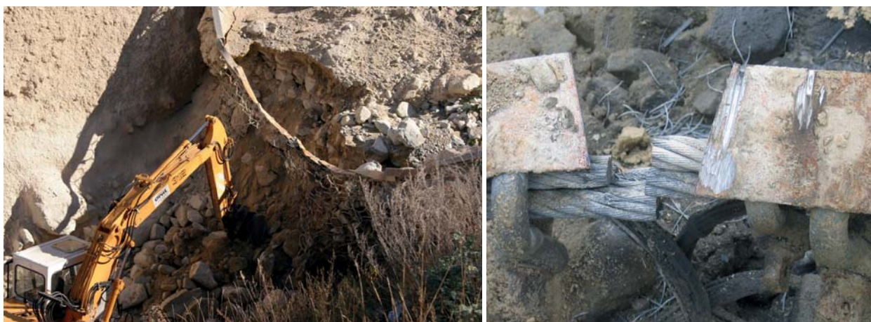
Abbildung 3.16: Abbau der Ringnetzbarriere im Illgraben 2006: Durch Aufschneiden des Ringnetzes und Materialentnahme mit einem Bagger, wird das ganze Netz entlastet (links) und darauf folgt die Durchtrennung der oberen Tragseile (rechts)
