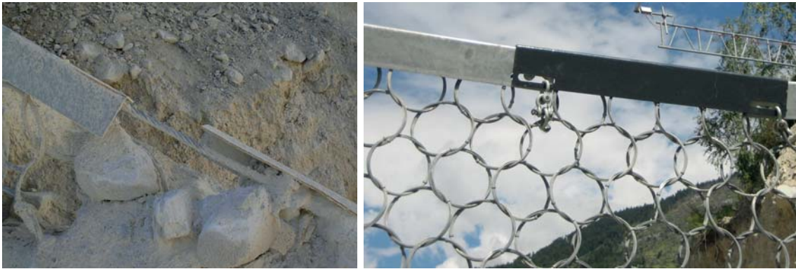
Abbildung 3.11: Auseinandergezogener Abrasionsschutz 2005 (links) und mit Langlöchern verschäkelter Abrasionsschutz 2007 (rechts)
