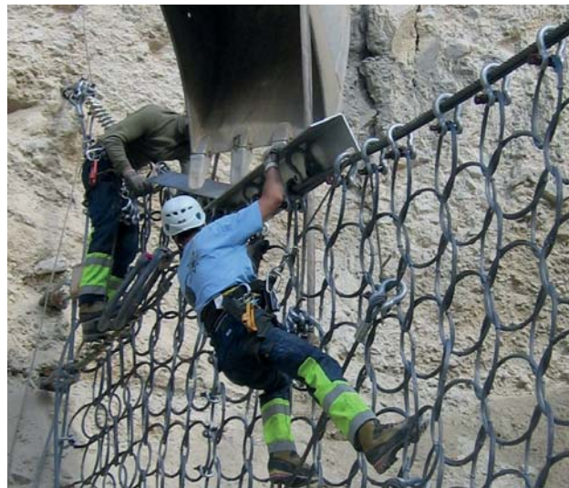
Abbildung 3.15: Montage des Abrasionsschutzes mit einem Bagger
