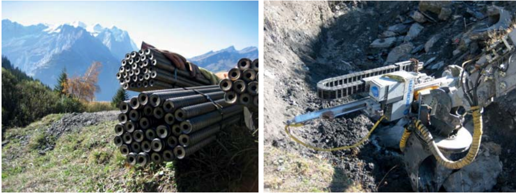
Abbildung 3.12: Selbstbohranker Titan 40/16 mit Rohrquerschnitt zum Einpressen des Injektionsmörtels (links) und Bohrgerät zum Setzen der Selbstbohranker (rechts)
