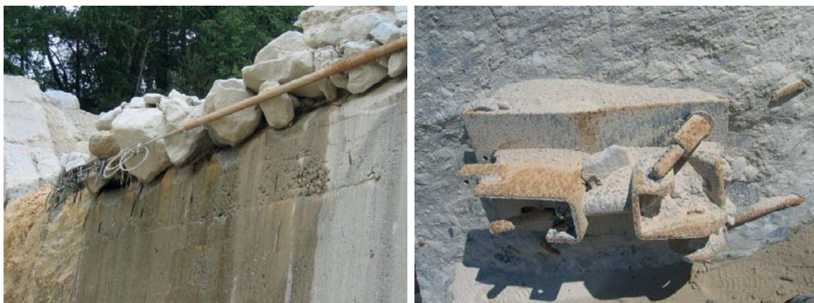
Abbildung 8.3: Verzinkte Stahlprofile auf Schwelle 28 im Illgraben nach dem ersten Murgang (links) und Grundplatte einer Stütze nach drei Murgängen (rechts)
