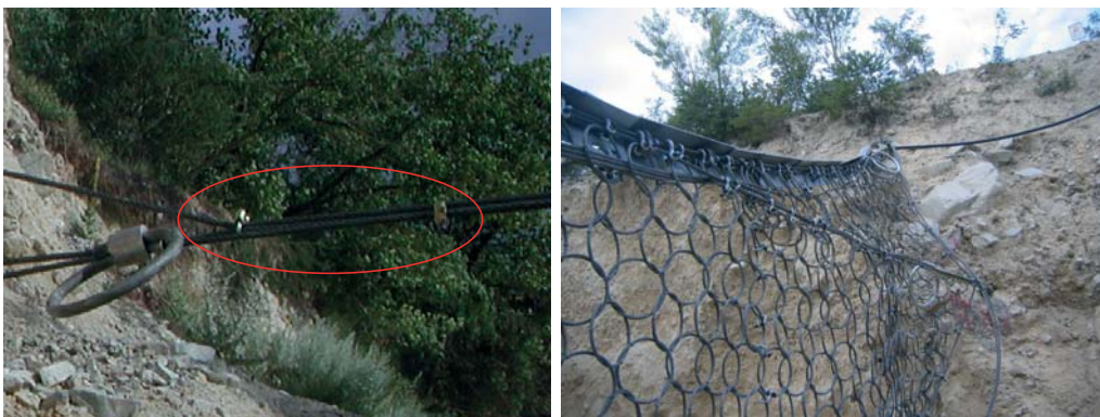
Abbildung 4.31: Befestigung des Flügelseils bzw. der oberen Tragseile am Horizontalseil: Variante alt mit Klemme punktuell (links) und durch grosse Schäkkel kontinuierlich (rechts)
