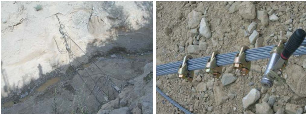
Abbildung 3.13: Gespannte Tragseile mit Bremsringen (links) und Fixierung der Tragseile mit Seilklemmen (rechts)
