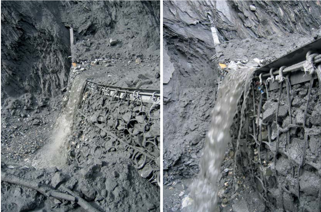
Abbildung 7.33: Negative Formgebung (links) und positive Formgebung (rechts) zur Vermeidung von Korrosionseffekten am Ringnetz
