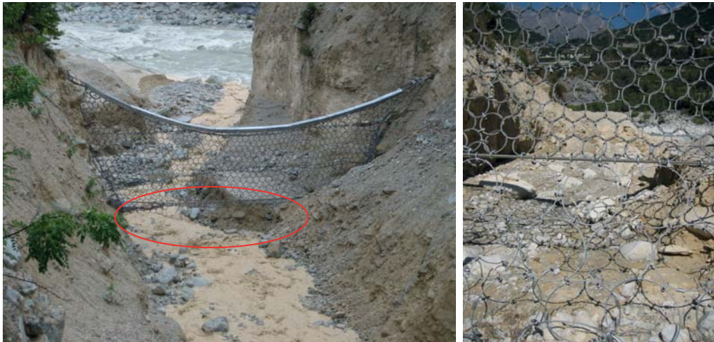
Abbildung 4.17: Durch Hochwasser vergrößerter Basisdurchlass (links) und Folgemassnahme an der Barriere durch zusätzliche Ringe mit einem Durchmesser von 0.7\text{ m} (rechts)
