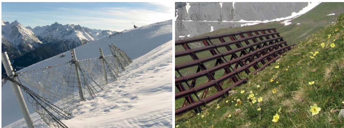
Abbildung 3.1: Schneenetzverbau (links) und starrer Verbau mit Schneebrücke (rechts)
