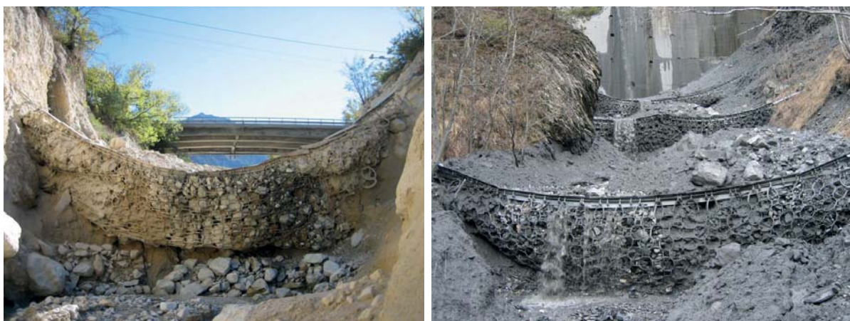
Abbildung 1.2: Gefüllte Testbarriere 2006 im Illgraben VS (links) und die drei Mehrstufenbarrieren im Merdenson VS (rechts)
