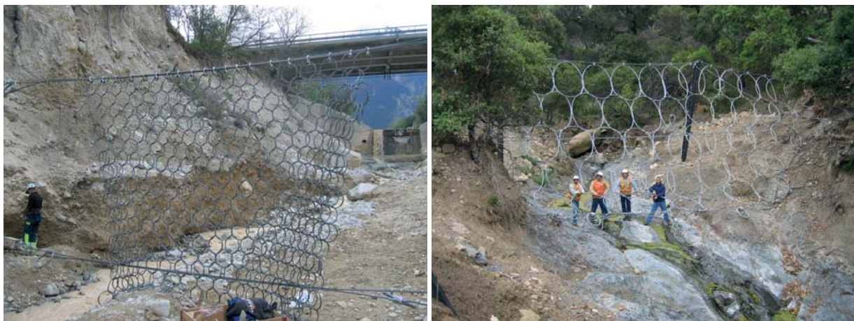
Abbildung 3.9: Aufziehen des Ringnetzes analog zu einem Vorhang bei der Montage (links) und alternative Maschenweiten am Gaviota Pass CA
