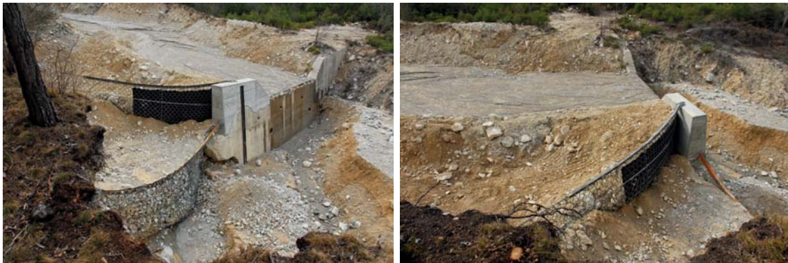
Abbildung 7.34: Geometrisch gebundene Wahl der Randbedingungen bei der Ergänzung durch eine Netzbarriere an ein bereits vorhandenes Bauwerk, Illgraben VS, Schwelle 25
