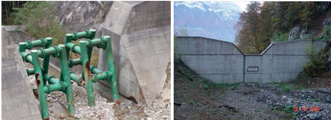
Abbildung 2.10: Rückhaltebauwerk kombiniert mit Stahlsäulen in Japan (links) und Geschiebesammler aus Beton in Bönigen BE (rechts)
