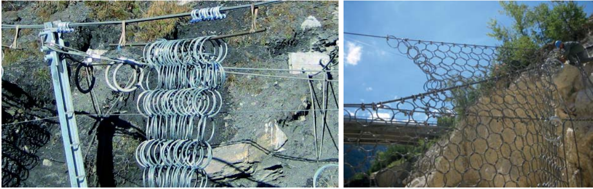
Abbildung 3.14: Zum Verschäkeln vorbereitetes Ringnetz an Eisenstangen aufgehängt (links) und Ringnetz am Montageseil aufgezogen zum Verschäkeln (rechts)
