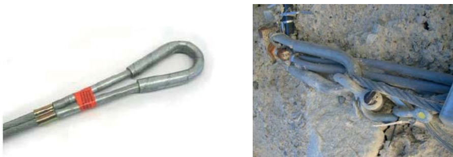
Abbildung 3.8: Spiralseilanker (links) und Flexkopf auf Selbstbohranker im belasteten Zustand bei gefüllter Murgangbarriere (rechts)
