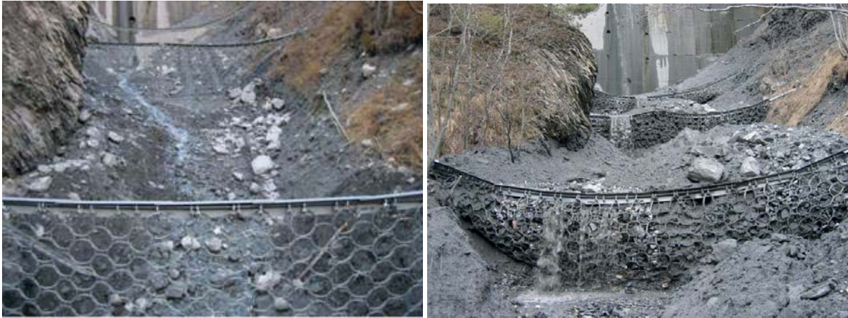
Abbildung 3.21: Installierte Serie von drei Netzen im Merdenson im ungefüllten (links) und gefüllten Zustand (rechts)
