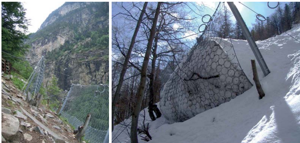
Abbildung 3.2: Steinschlagschutzverbauung oberhalb von Gondo VS (links) und durch einen Schneerutsch gefülltes Steinschlagnetz in Fieberbrunn Tirol
