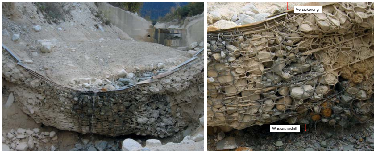
Abbildung 4.15: Barriere 2006 nach dem Füllereignis (links) und neuer Abflussweg durch Versickerung im August 2006 (rechts)
