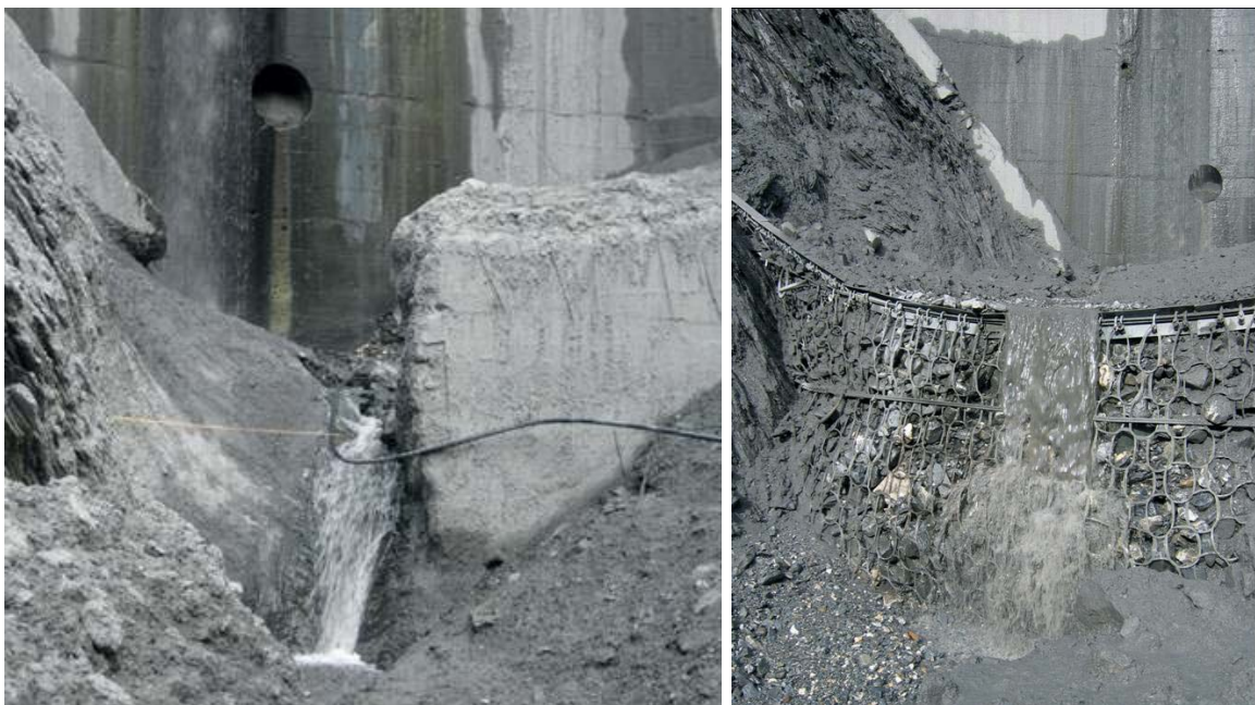
Abbildung 3.24: Ausgekolkte alte Betonsperre (links) und verfüllter Zustand Barriere 1 als Kolkschutz der alten Betonsperre (rechts)
