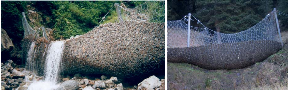
Abbildung 3.3: Steinschlagbarrieren durch Murgänge belastet, links in Japan Aobandani 1998 und rechts in St. Anton Vorarlberg 2005
