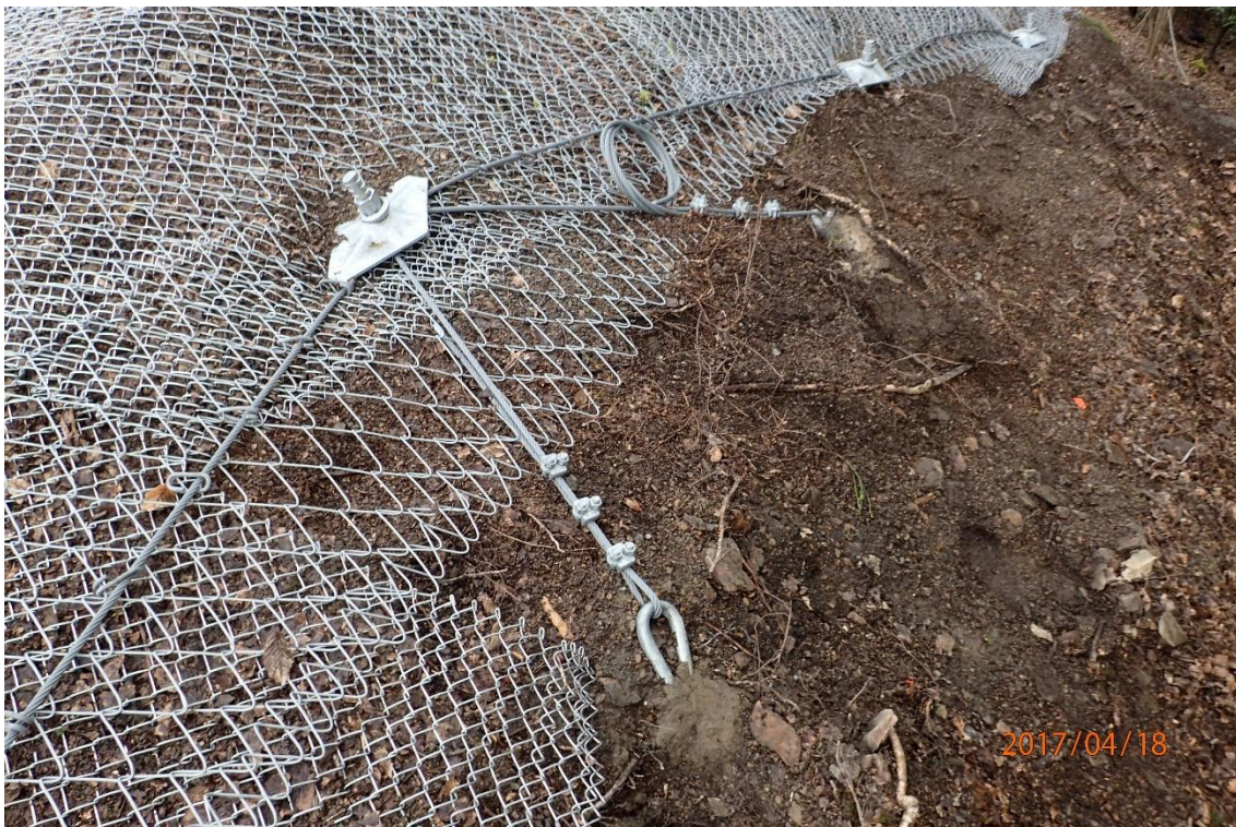
Bild 14: Spiralseil-Anker zur Abspannung der Übernetzung (2016/2017)
