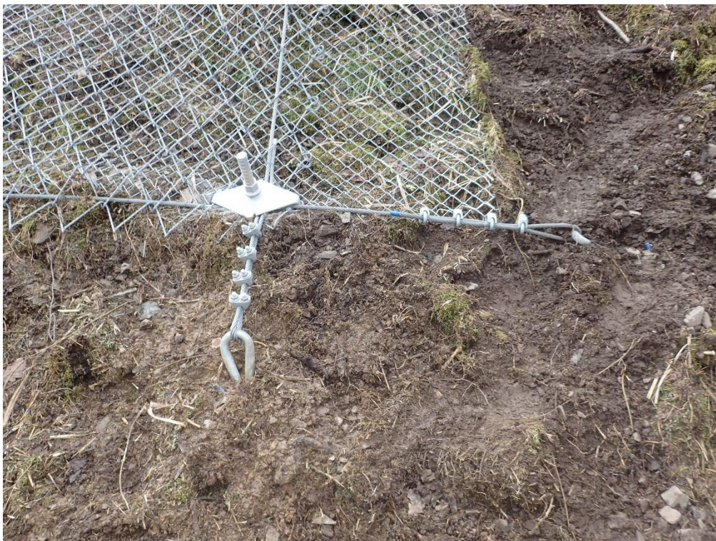
Bild 8: Spiralseil-Anker zur Abspannung der Übernetzung (2014/2015)
