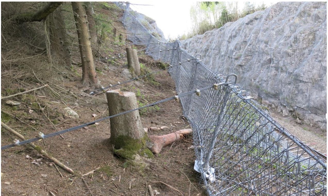
Bild 10: Rückgespannte Auffangschürze System Tecco (2013/2014)
