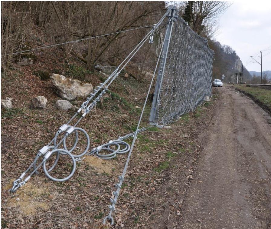
Bild 12: Seilabspannungen vom Fangzaun (2012/2013)
