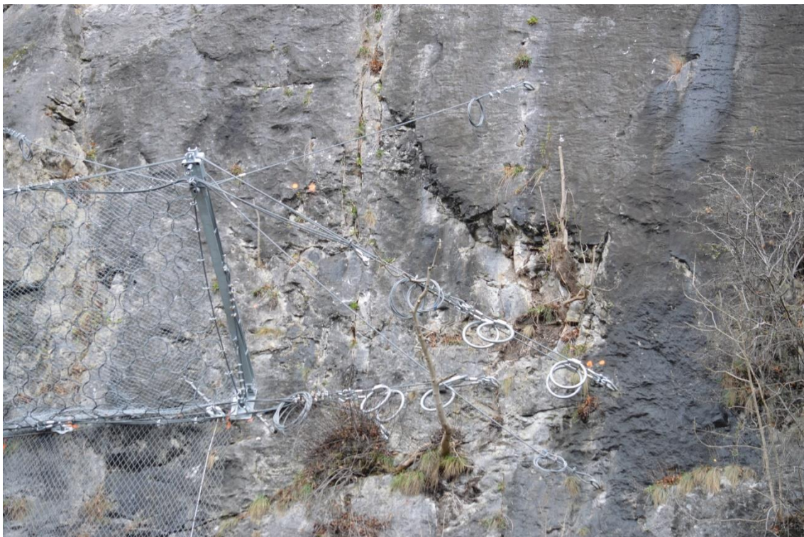
Bild 2: Seilabspannungen vom Fangzaun (2013/2014)
