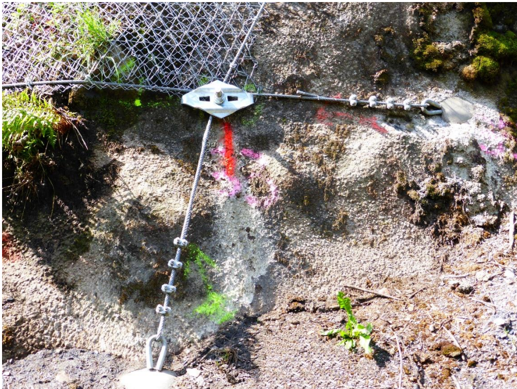
Bild 4: Verankerung der Randseile über Spiralseil-Anker (2014)
