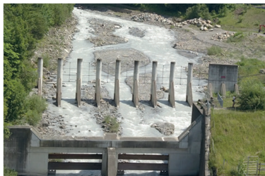
Sperre unterwasserseitig (Bild: [F]).
