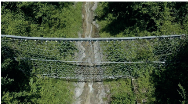
Mehrstufenverbau
