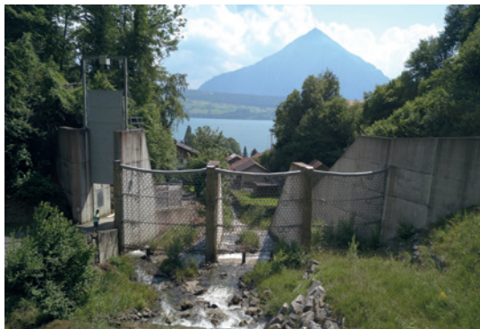
Sperre oberwasserseitig (Bild: [F]).
