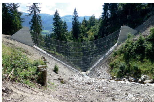
Sperre oberwasserseitig (Bild: [F]).
