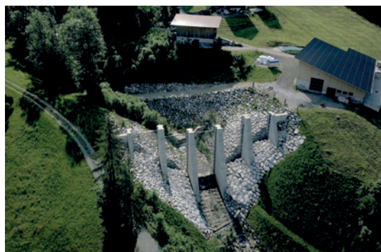
Sperre unterwasserseitig (Bild: [F]).
