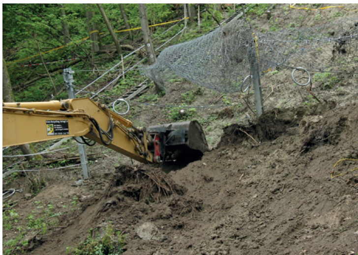
Leerung eines Hangmurenschutznetzes von der Talseite her mit Bagger.
