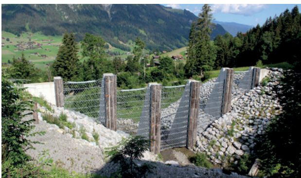
Netzbauwerk mit Betonpfeilern
