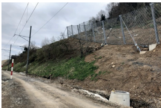
Blick auf die Verbauung von unten (Bild: [H]).
