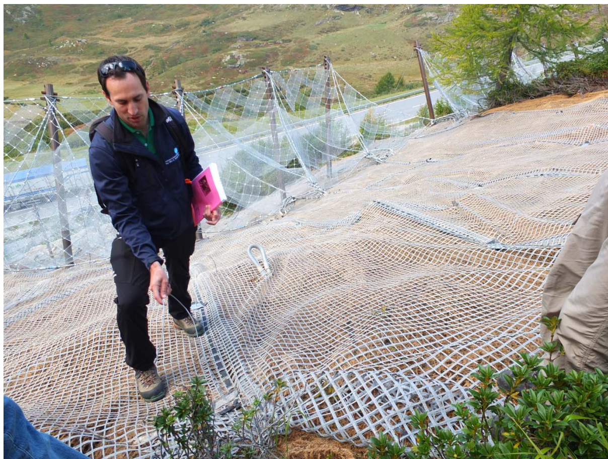
Figur 53. Der terrenget er ekstra bratt og utsatt for jordsig er det valgt å legge geotekstiler mellom radene. Dette for å binde jorda bedre sammen (Foto: Audun Langelid)
