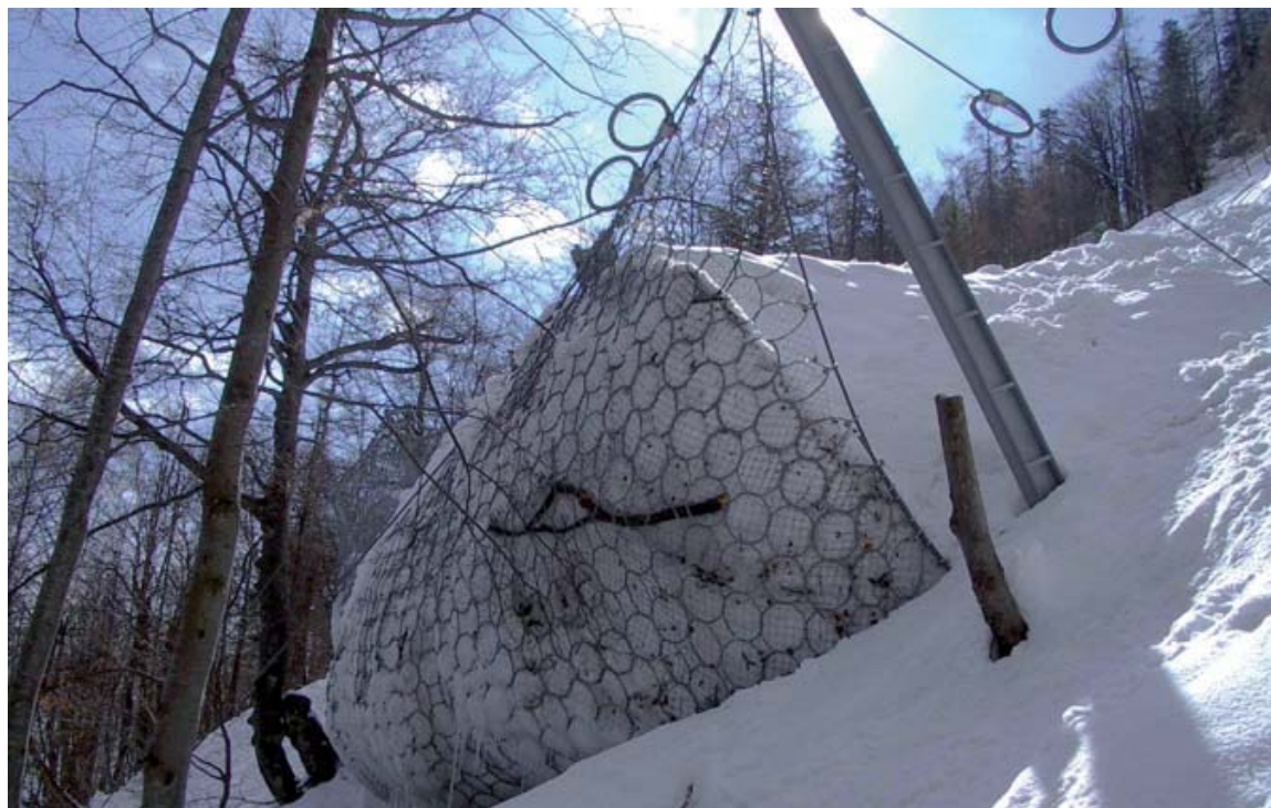
Figur 23. Her har et fanggjerd blitt fylt opp av snømasser i et testområde i Fieberbrunn i Østerrike. Legg merke til fleksibiliteten i gjerdene (Foto: Geobruugg)
