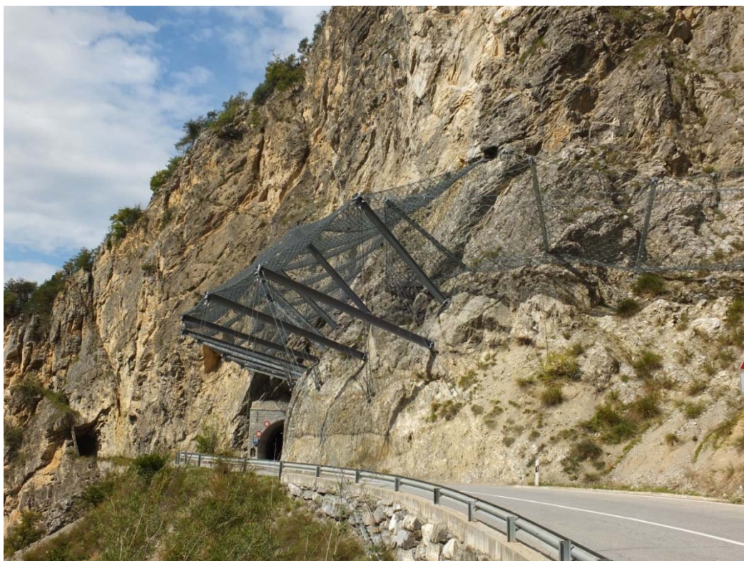
Figur 66. Geobrudd har utviklet et selvrensende fanggjerd for steinsprang som i noen tilfeller kan erstatte tunnel og overbygg (Foto: Gunne Håland)
