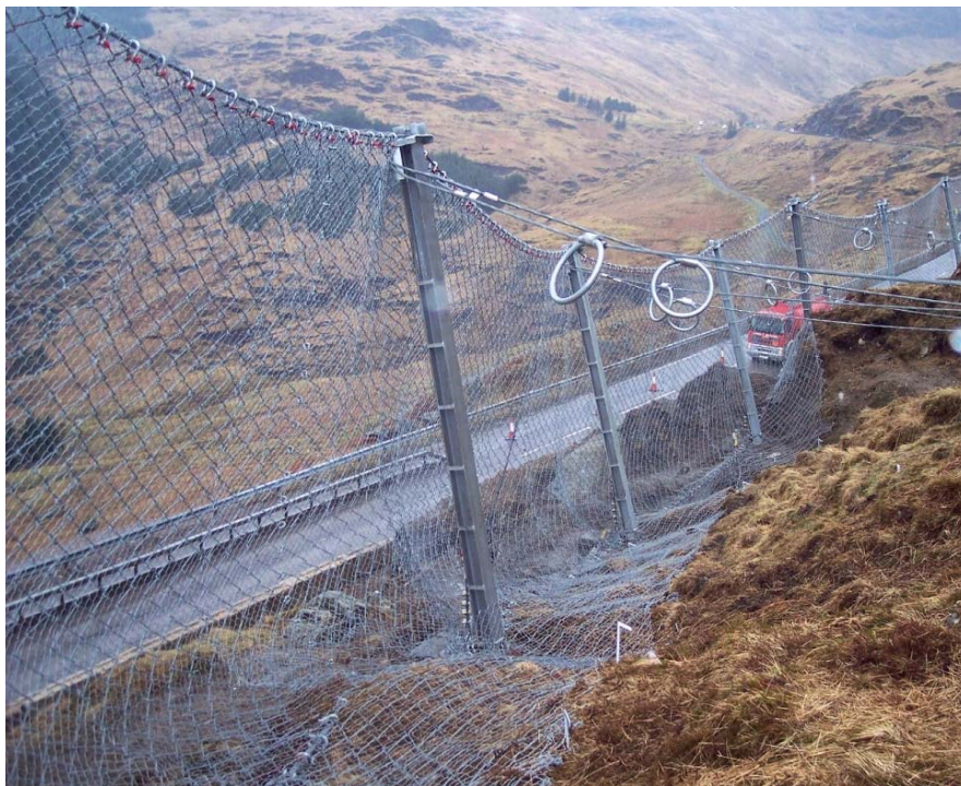
Figur 21. SL - 150 fanggjerdet installert for å fange opp jordskred i Skottland. Legg merke til at man har trukket sikringsnettet tilbake langs bakken (Foto: Geobrugg)
