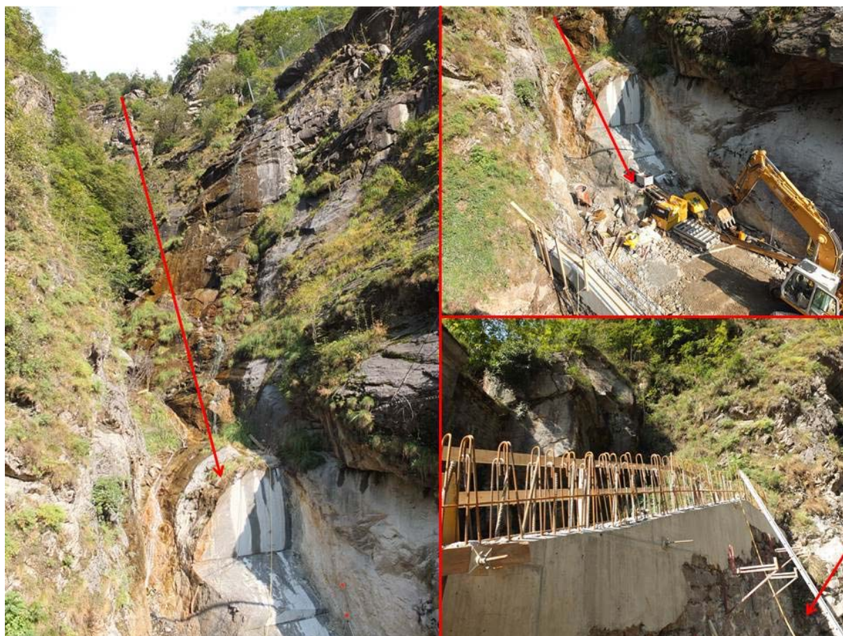
Figur 45. Bilde til venstre viser bekkeløpet som kommer ned i en trakt i fjellskrenten. Området rett under pilen er berg som er tatt bort for å få stort nok lagringsvolum i dammen. De andre bildene viser betongkonstruksjonen som er under bygging mellom bekk og jernbane. Rød pil indikerer bekkeløpet (Foto: Gunne Håland)
