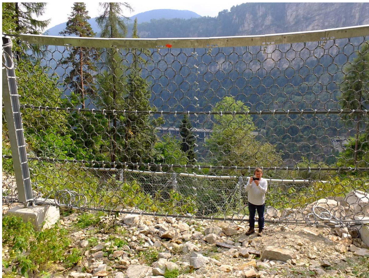
Figur 34. Begge gjerdene sett med skredretningen. (Foto: Gunne Håland)
