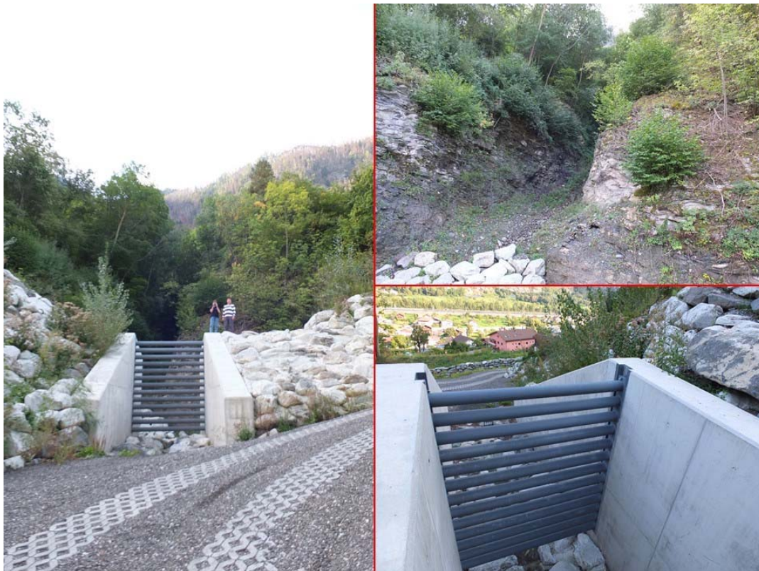
Figur 59. Det øverste bassenget har som formål å stoppe de groveste massene i flomskredet. Bilde oppe t. h viser kanalen i bakkant som skredet dreneres gjennom. Bilde nede t. h viser energibaren der jernrør er satt på skinner (Foto: Gunne Håland og Audun Langelid)
