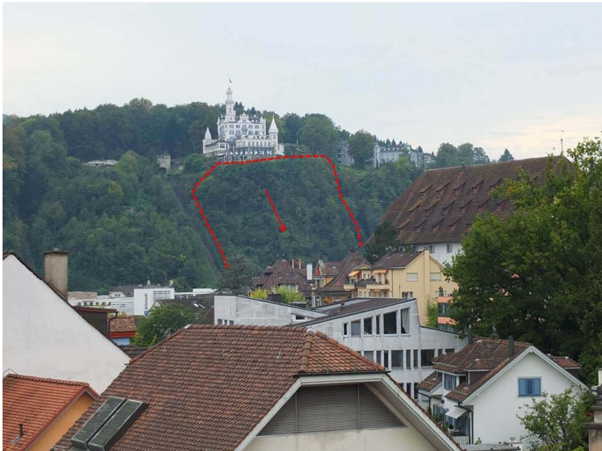
Figur 80. Det ligger en bratt jordskråning over en rundkjøring der man frykter det kan gå et jordskred. Toppen av skråningen går over i et flatt platå der det ligger et slott (Foto: Gunne Håland)
