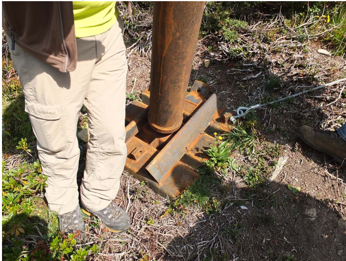
Figur 52. Fundamentplata til gjerdestolpene ikke er forankret i fjell, men er naglet fast til jorda ved vekten til stolpene (Foto: Audun Langelid)
