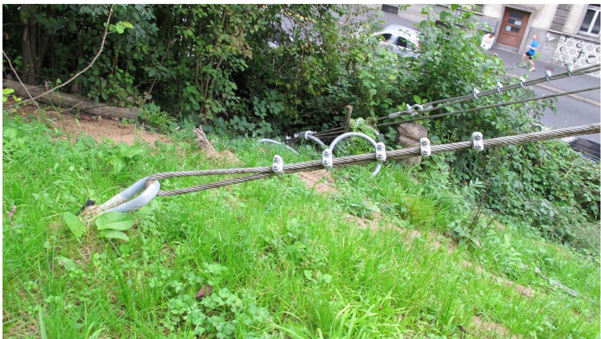
Figur 82. Støttewirene er forankret til bakken med wirebolt (Foto: Audun Langelid)
