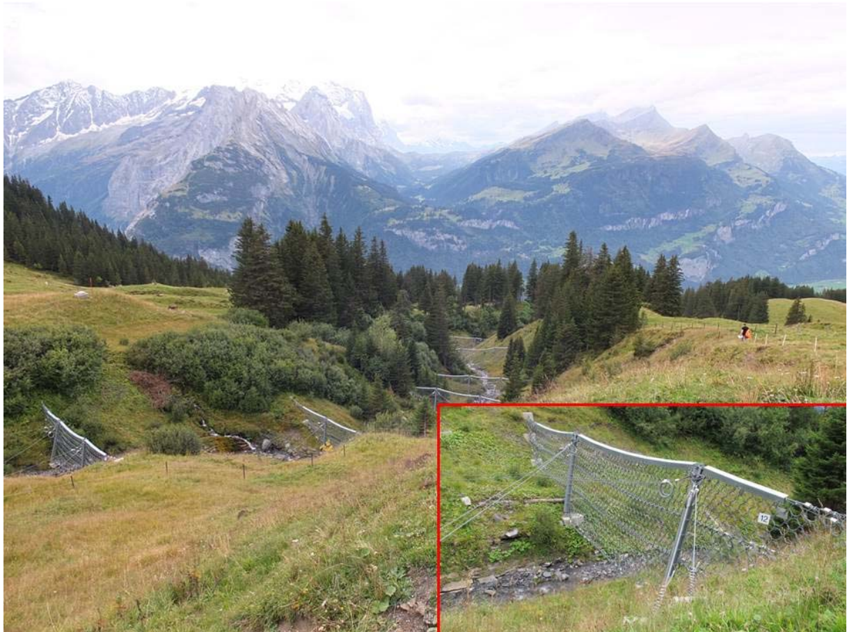
Figur 75. Det er satt opp 13 fleksible ringnett barrierer øverst i en elv for å hindre at det utvikler seg flomskred (Foto: Gunne Håland og Audun Langelid)
