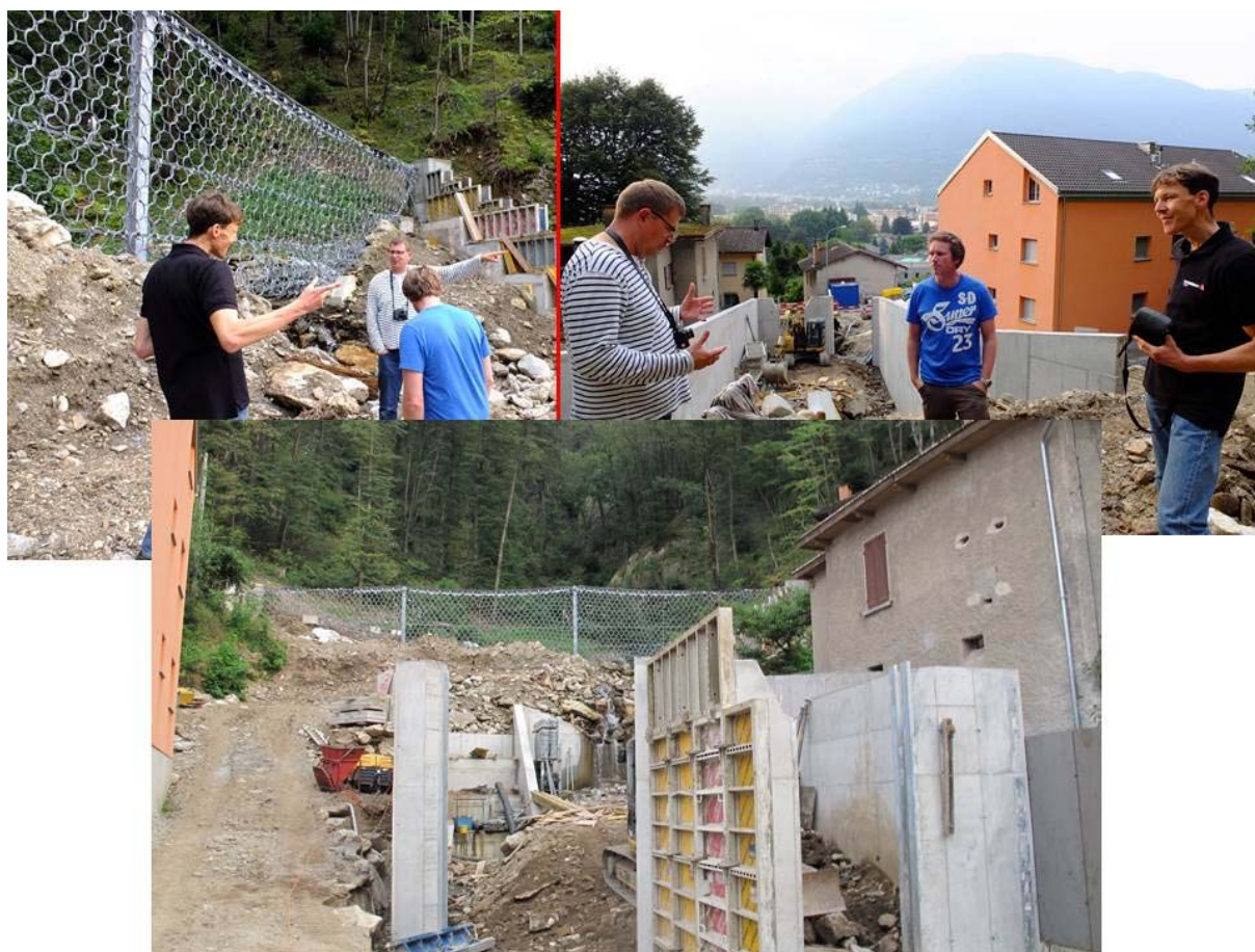
Figur 38. Lokalitet ved Jaubiajco. Her skal noen hus i en landsby sikres med fleksible ringnett barrierer kombinert med en fangdam, ledevoll og energidreper i betong (Foto: Gunne Håland og Audun Langelid)
