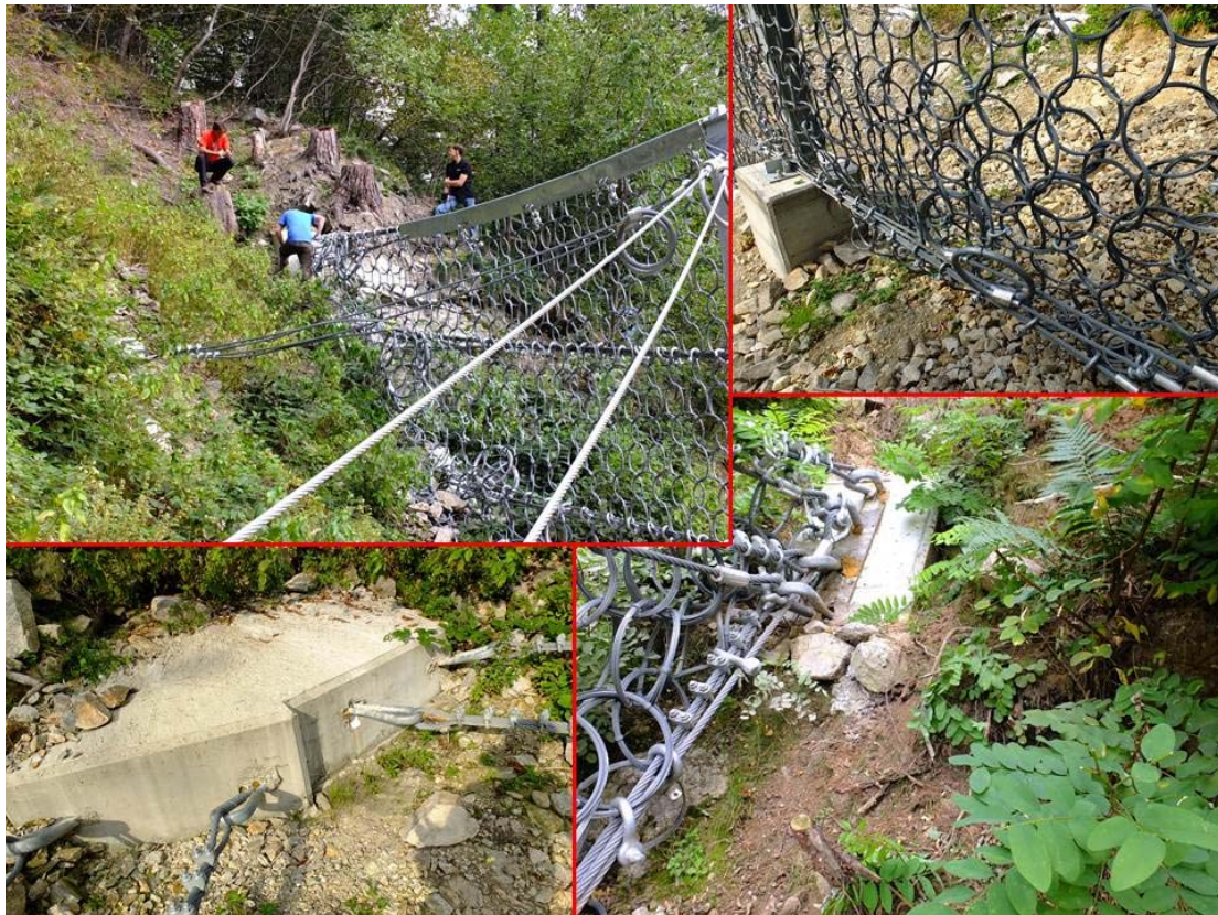
Figur 36. Forankringsmetode (Foto: Gunne Håland og Audun Langelid)
