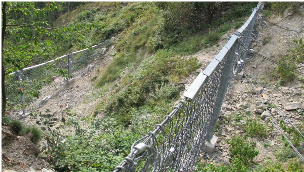
Figur 33. Trafostasjonen til jernbanen blir sikret med to fleksible ringnett- gjerder i kanalen. Det fremste gjerdet (til venstre i bildet) har en høyde på 6 meter og er det høyeste av denne typen i Sveits. Det bakerste gjerdet er på 5 meter (Foto: Audun Langelid).
