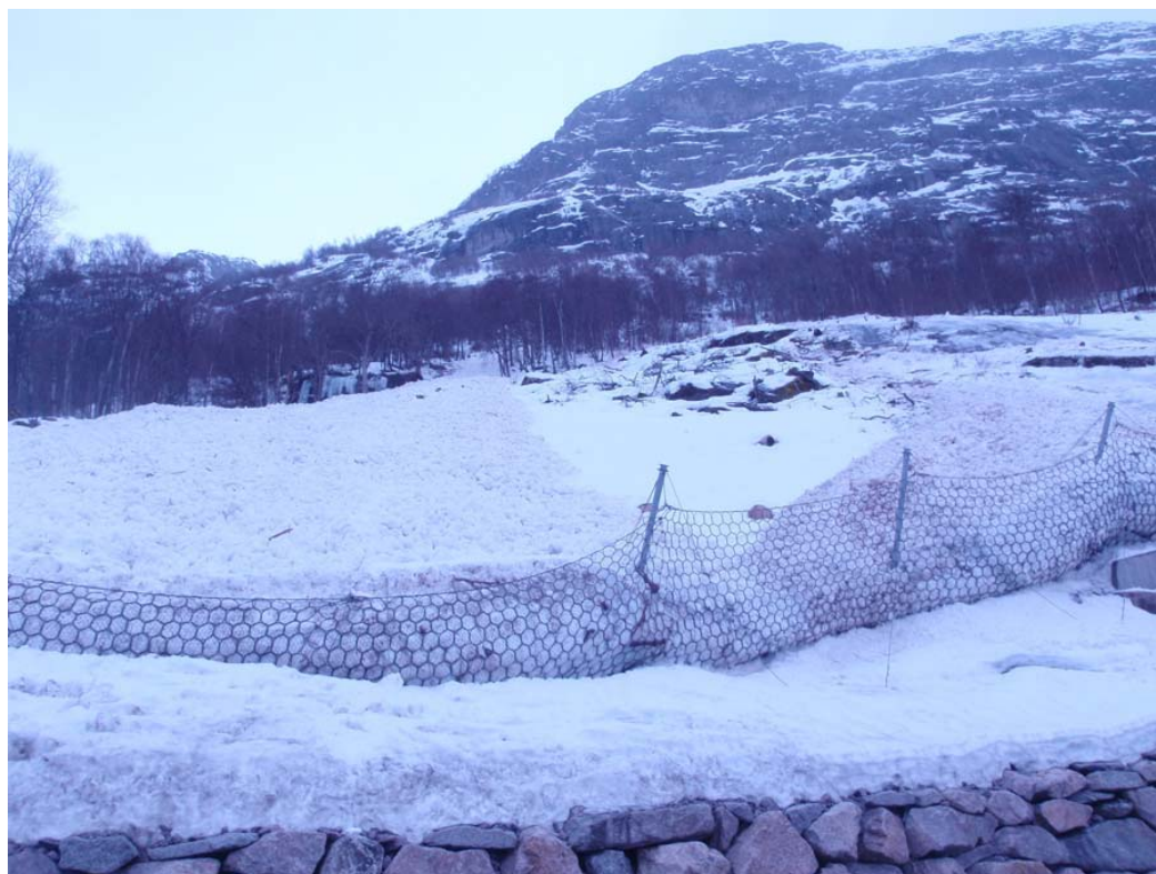
Figur 85. Skredmasser har fylt opp gjerdet fra to forskjellige skredløp. Terrenget over består av bratt svaberg (Foto: Kristian Kjesbu)
