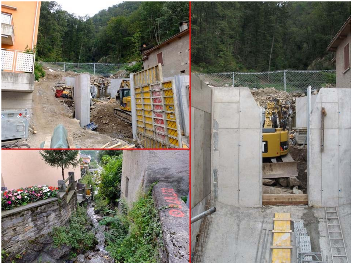
Figur 40. Betongdammen har som hensikt å lede vann og suspenderte masser fra eventuelle flomskred kontrollert til elven som går gjennom landsbyen (Foto: Gunne Håland og Audun Langelid)
