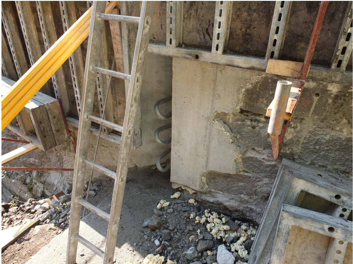
Figur 46. Veggene i betongdammen er 5 meter tykke. Det er brukt staganker som forankringsmetode med en ankerdybde på 6 meter for innfestingen til fanggjerdet (Foto: Gunne Håland)
