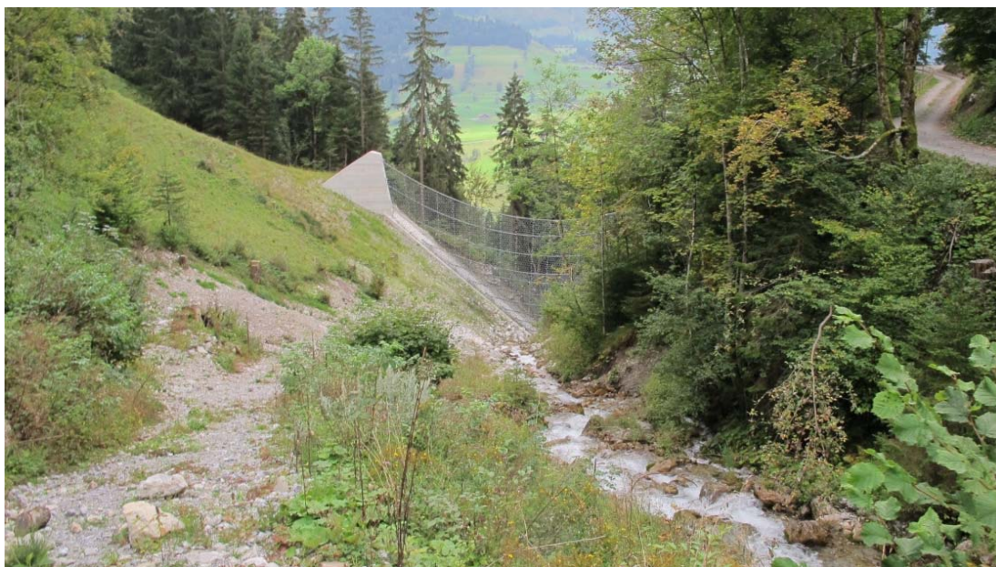
Figur 70. Det er stor lagringskapasitet bak gjerdet (Foto: Audun Langelid)
