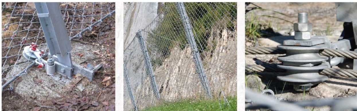
Figur 9. Fra venstre: bunnplaten til gjerdestolpene, gjerdestolper og trinse (Foto: Geobrugg)
