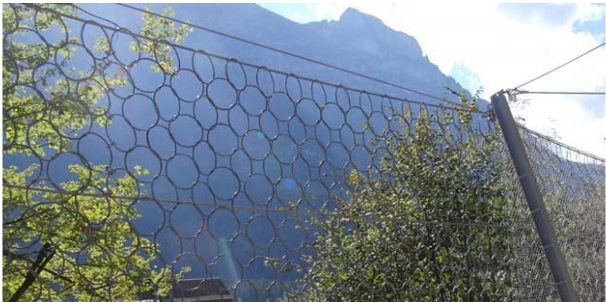
Figur 7. RXE gjerdet med Rocco ring nett (Foto: Geobrugg)
