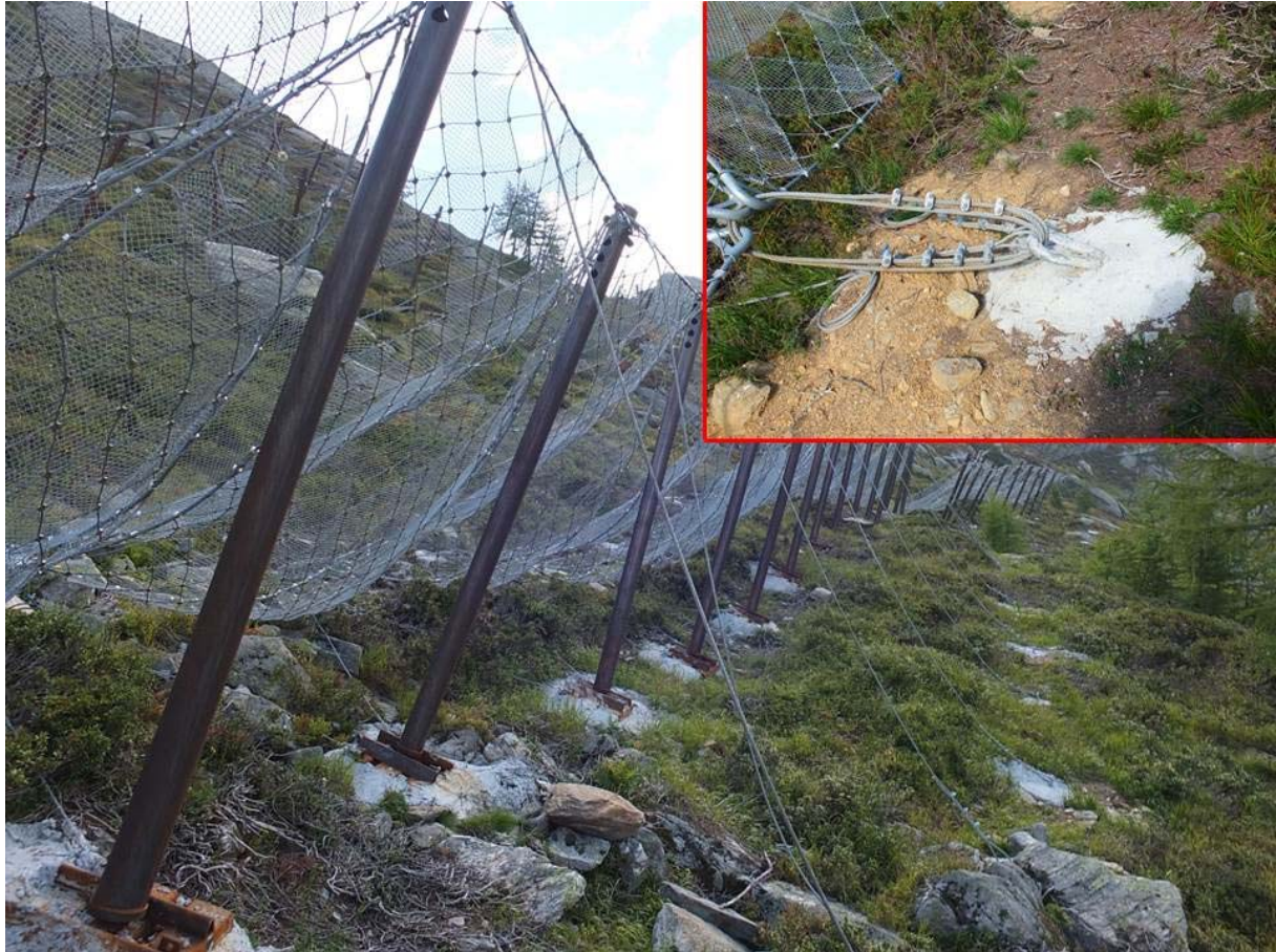
Figur 54. Det er en utfordring med rett maskestørrelse i gjerdene. Det er viktig at den nedre støttewiren er passe stram. Bilde oppe til høyre viser hvordan nettene festes til bakken (Foto: Audun Langelid)
