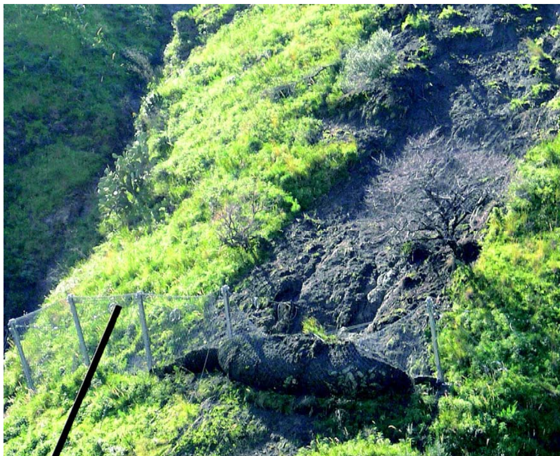
Figur 19. Geobrudd leverer fangggjerdene som er utviklet for å fange opp mindre/grunne jordskred (Foto: Geobrudd)
