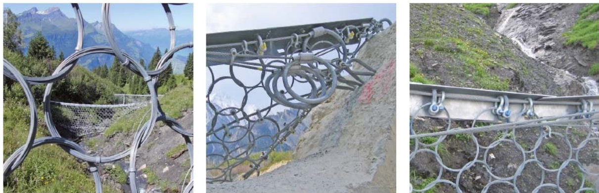
Figur 17. Fra venstre: Rocco ringnett, bremseringer, beskyttelse av bærewire (Foto: Geobrugg)
