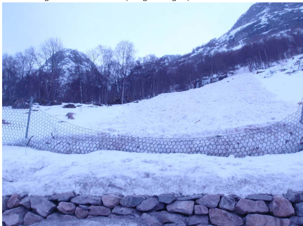
Figur 84. Skredmasser har fylt opp gjerdet og knekt 2 stolper (Foto: Kristian Kjesbu)
