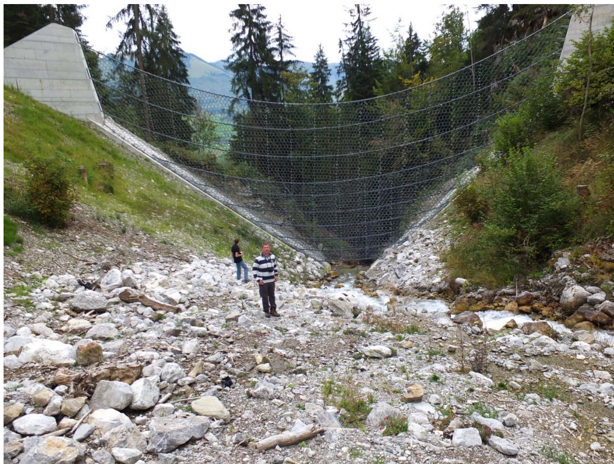
Figur 68. I 2013 ble verdens største fleksible ringnettbarriere satt opp for å sikre landsby (Oberwill), veg og jernbane mot et stort flomskred man frykter kan komme her en gang i fremtiden (Foto:Gunne Håland)
