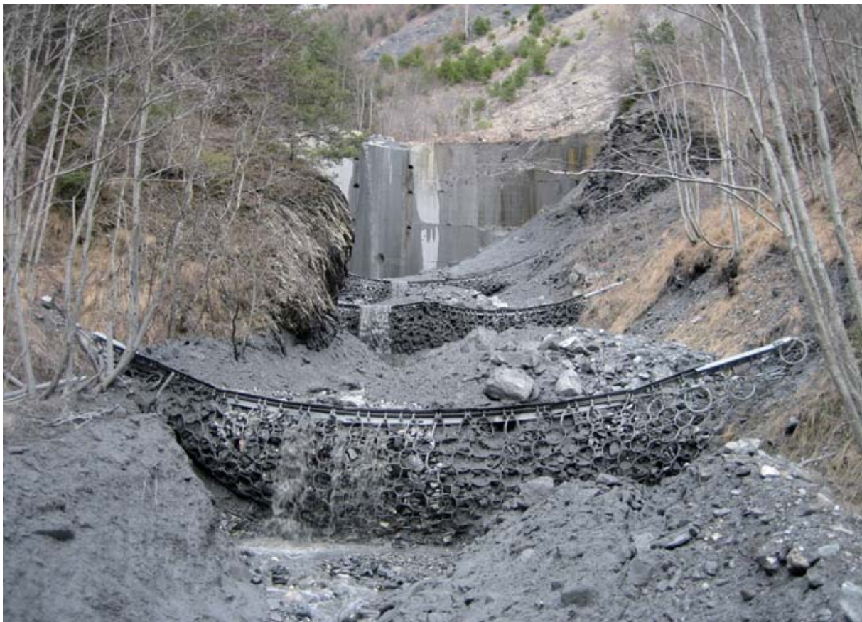
Figur 12. Fleksible ringnett-gjerdet (Foto: Geobrugg)
