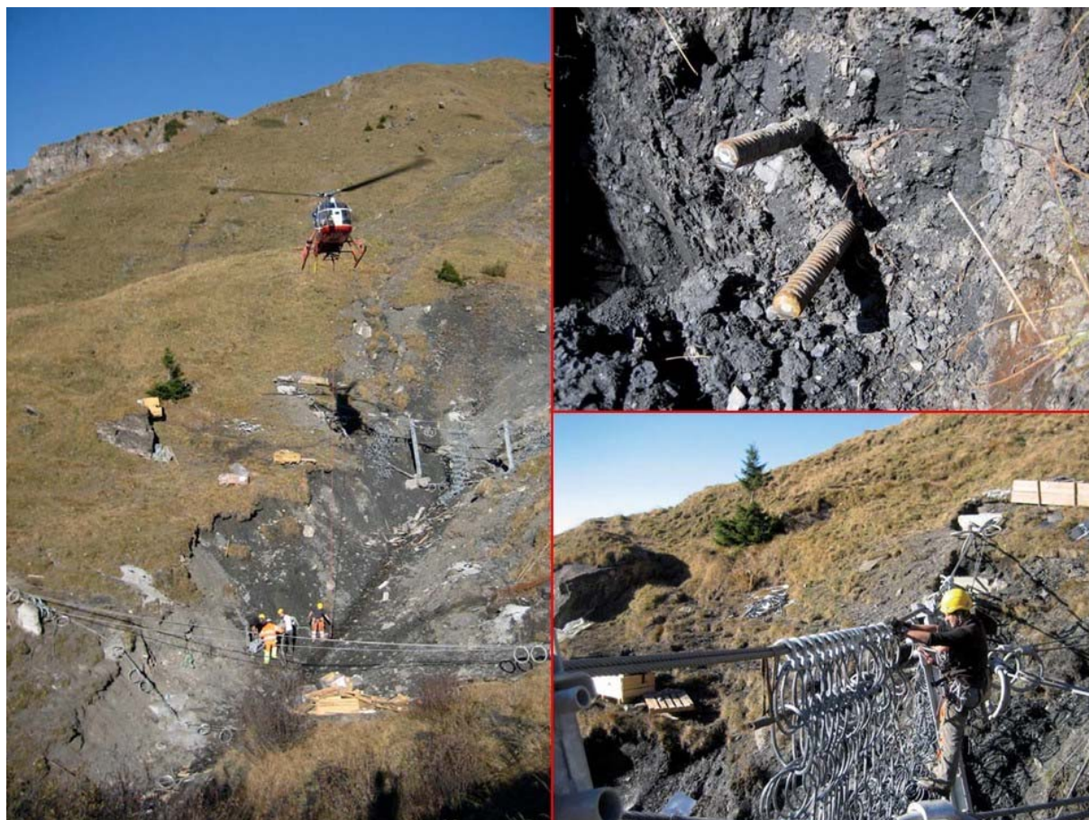
Figur 78. Installering av gjerdene i 2007/2008. Gjerdene ble fraktet opp med helikopter. Bilde oppe t.h viser anker i kanalveggen, og bilde nede t.h viser festingen av ringnettene (Foto: Geobrugg)
