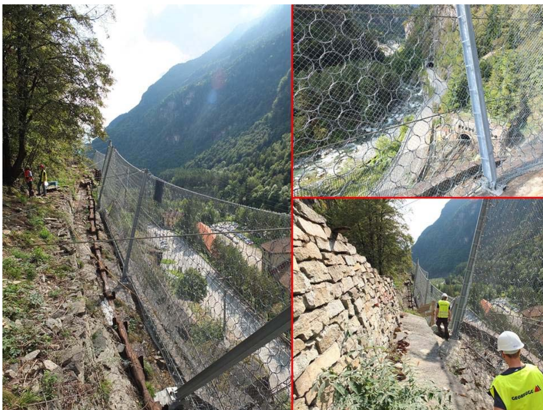
Figur 48. RXE fanggjerd med Rocco ringnett og Tecco som innernett. Gjerdene er plassert i høyere områder i skrenten (Foto: Audun Langelid)
