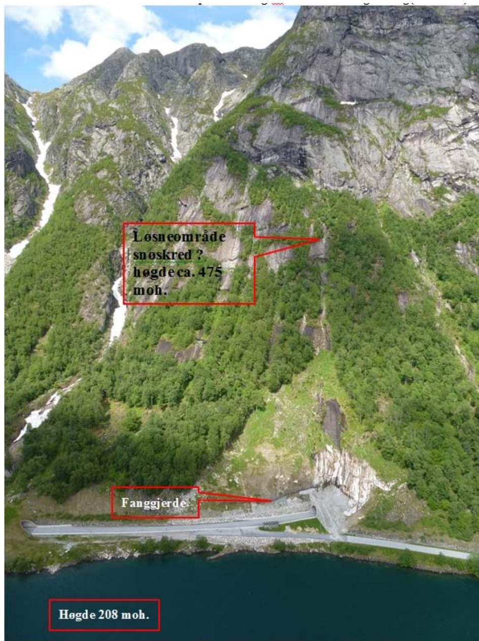
Figur 83. Viser antatt løsneområdet til snøskredet og plassering av fanggjerdene (Foto: S. H. Frækaland, 2011)
