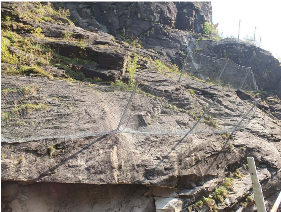
Figur 47. GBE-gjerder med Spider sikringsnett, plassert nederst i skrenten (Foto: Gunne Håland)
