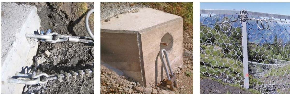
Figur 18. Fra venstre: wireanker, selvboret stag med et fleksibelt hode, gjerdestolper (Foto: Geobrudd)
