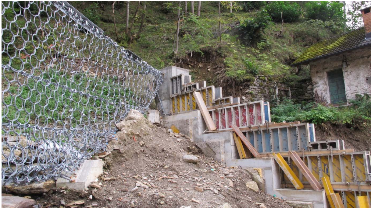
Figur 39. Det er støpt store betongklosser for å få god forankring i løsmassene (Foto: Audun Langelid)
