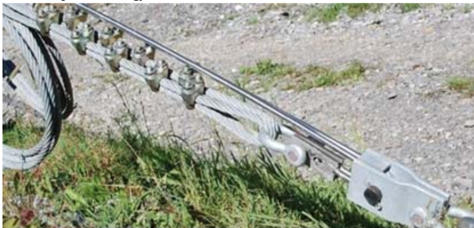
Figur 10. Bremseelement (U-brake system) i GBE - serien (Foto: Geobrugg)
