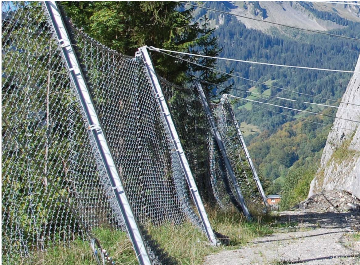
Figur 6. GBE - serien med Tecco - nett (Foto: Geobrugg)
