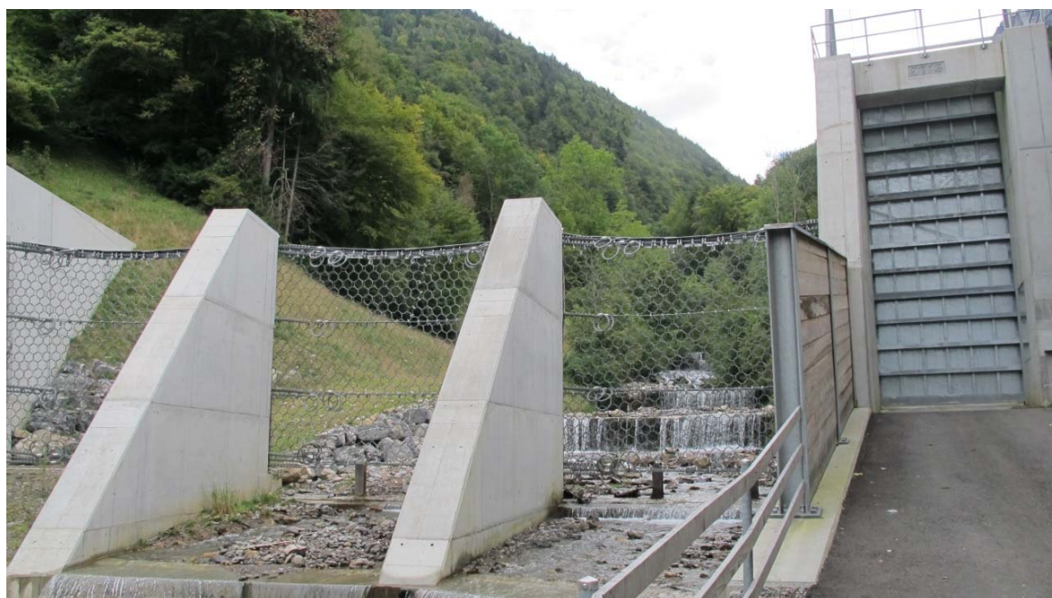
Figur 73. Bilde av konstruksjonen sett nedstrøms. Legg merke til bilporten til høyre i bilde (Foto: Audun Langelid)
