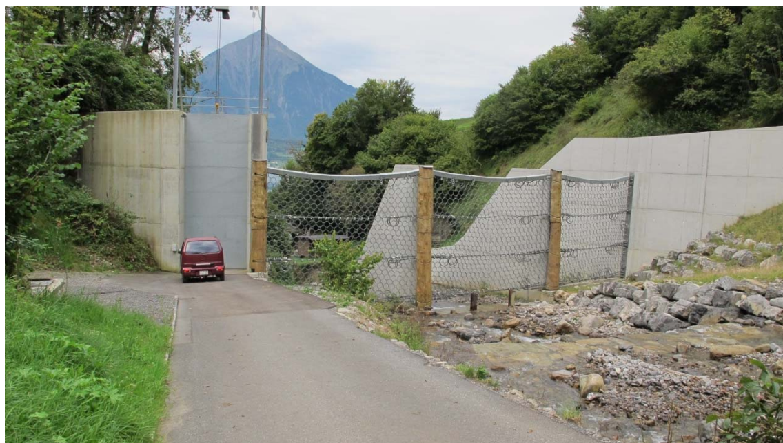
Figur 72. Bilde av sikringstiltaket oppstrøms, bilporten til venstre i bilde (Foto: Audun Langelid)
