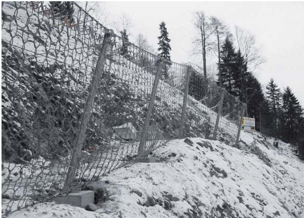
Figur 26. Her er et fanggjerd satt opp både mot steinsprang og mindre snøskred (Foto: Geobrugg)
