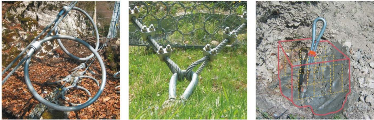
Figur 11. Fra venstre: bremsering, wireanker og selvboret stag med et fleksibelt hode (Foto: Geobrugg)
